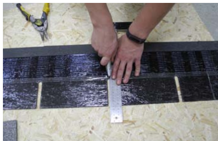
Рис. 7. Деление плитки на лепестки
